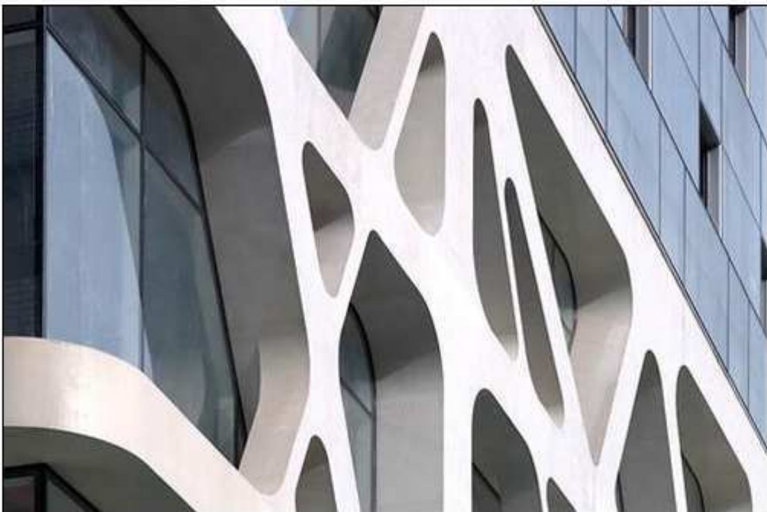
Cấu trúc bên ngoài của các tầng bên dưới khu thương mại
