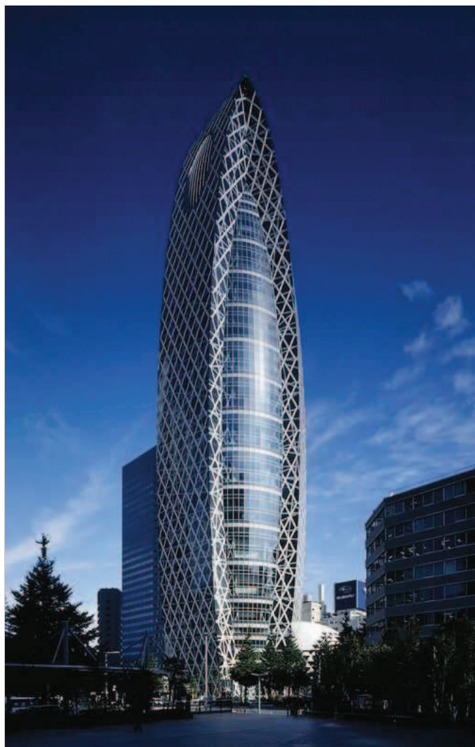
图2: 蚕茧大厦是一座校舍建筑, 外形酷似蚕茧, 采用钢架结构
